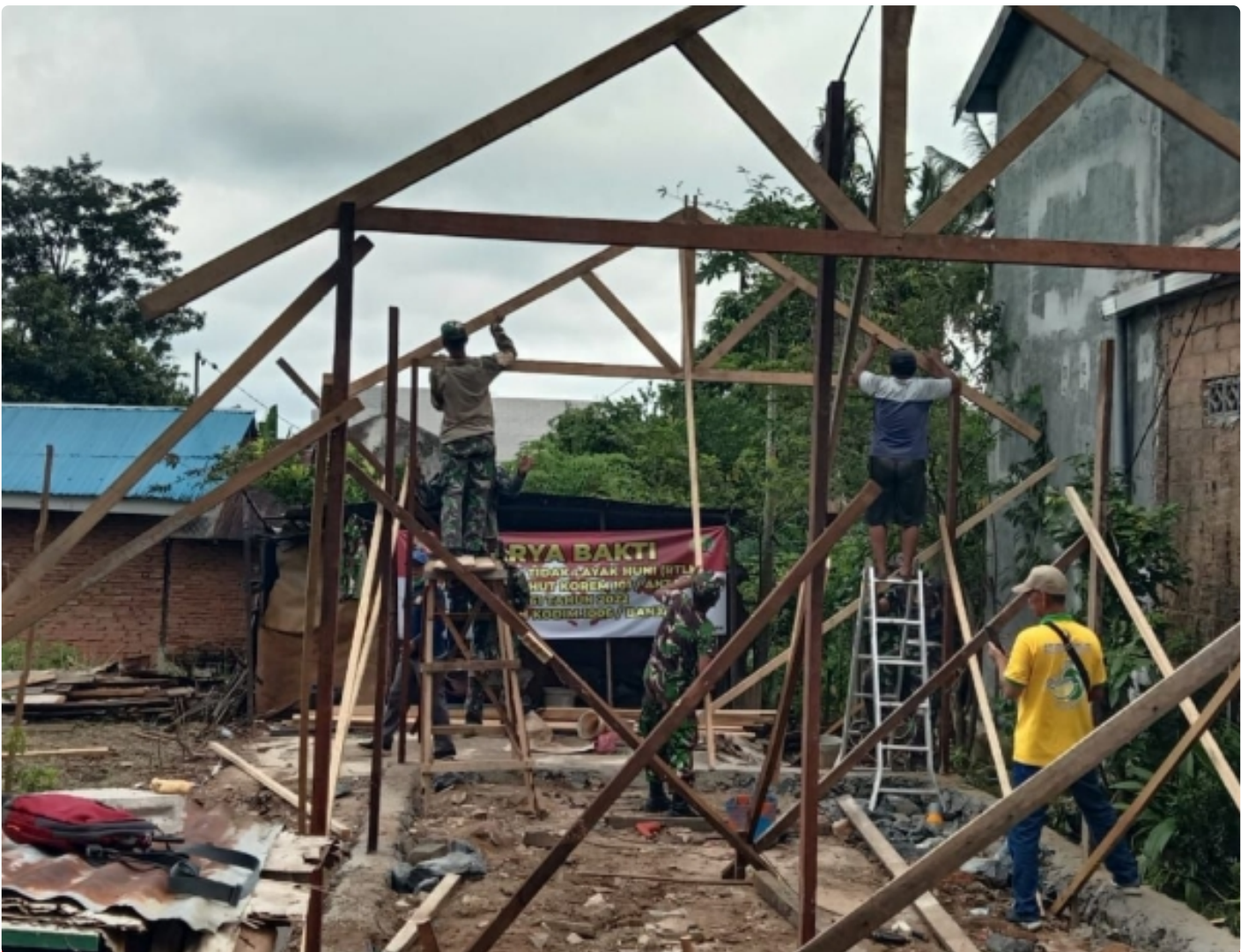
Setelah Dirobohkan " Kini Rumah Nursiah Dipasang Pondasi Dan Kuda - Kuda Rangka Rumah
